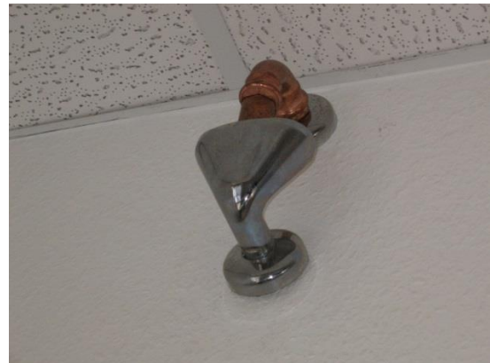
Korrekte Ableitung des Kondenswassers aus einem Umluftkühlgerät in der Decke.
