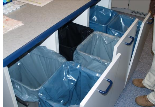
Abfalltrennung: Links keine Reinigung und Desinfektion der Behältnisse möglich, rechts saubere Sammlung ohne Kontamination der Behältnisse
