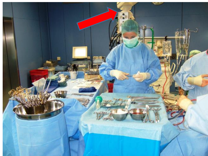
Roter Pfeil: Ende der TAV-Decke – viele Instrumente (links) stehen nicht im Schutzbereich (rechts).
