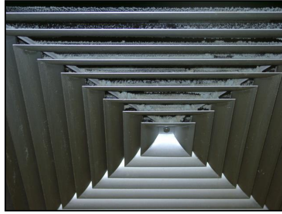
Die Abluft-Öffnungen erkennt man meist gut am Schmutz, der sich dort fängt.
